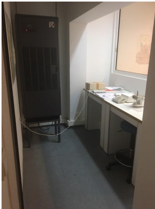
Φώτογραφια 4. Ζύγος ακριβειας σε δώματιο ελεγχομενου περιβαλλοντος. Απεικονιζονται ο ζύγος ακριβειας στον παγκο τού, η κλιματιστικη μοναδα τού δώματιού και μερος τών κούφώματων (παραθύρα) πού θα μεταφερθούν.
